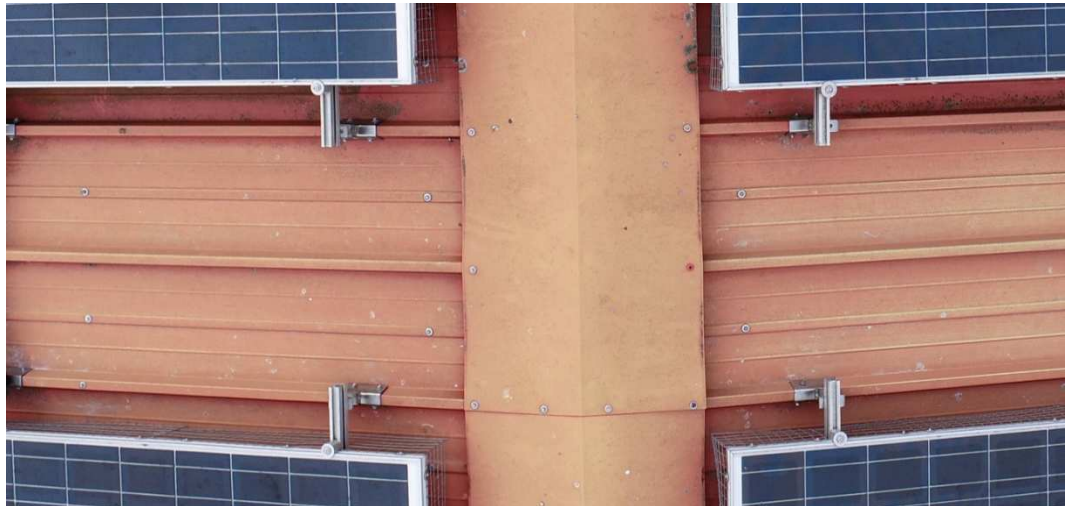
Abbildung 5.3: Metaldächer Ostendstr. 4 Detail: First Hauptdach
