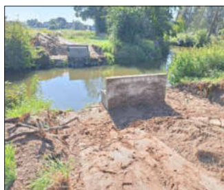
Freilegen der Widerlager durch Firma Wohlfahrt
