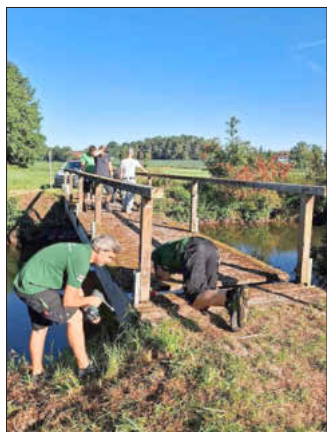
Freilegen der Widerlager durch Firma Wohlfahrt
