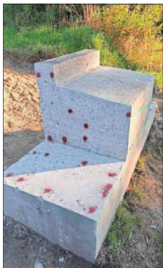
Widerlager nach Betonschneidearbeiten
