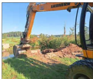
Freilegen der Widerlager durch Firma Wohlfahrt
