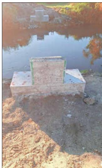
Widerlager nach Betonschneidearbeiten
